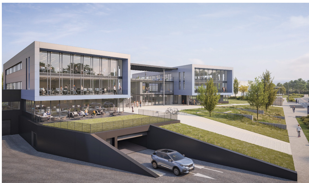
Opération Construire Pro Plug & Play par DCB International, Bâtiments E et F
